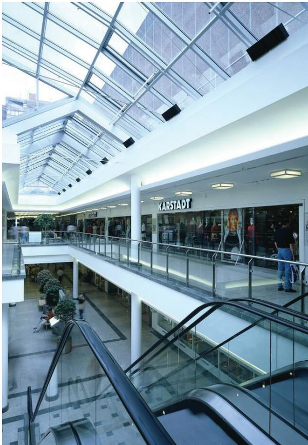
Kein durchgehendes Glasdach in der Ebene 2. Die Umlegung der gesamten Lufttechnik hätte die Baukosten extrem belastet.
